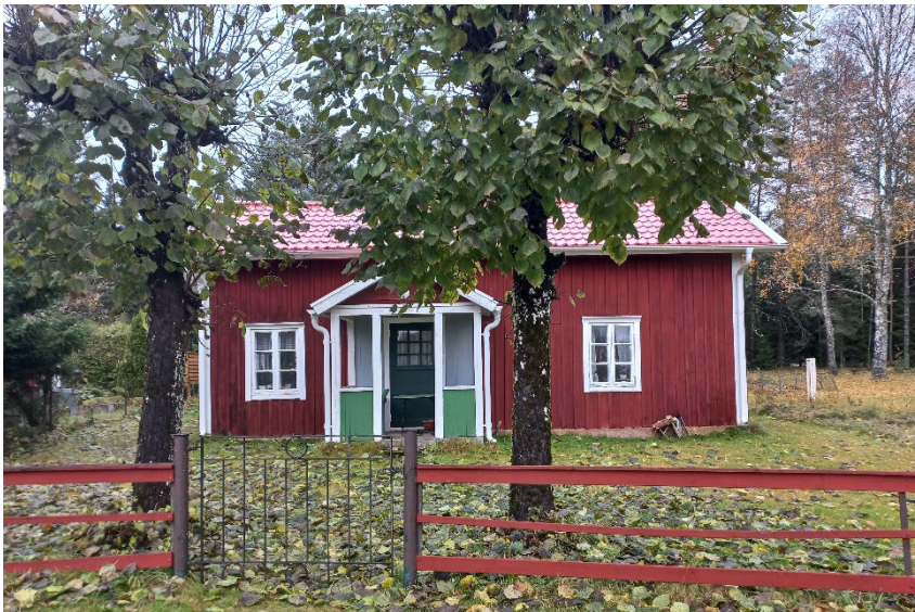
Backstuga uppförd på 1870-talet med bevarad karaktär. (2023-11-01)
