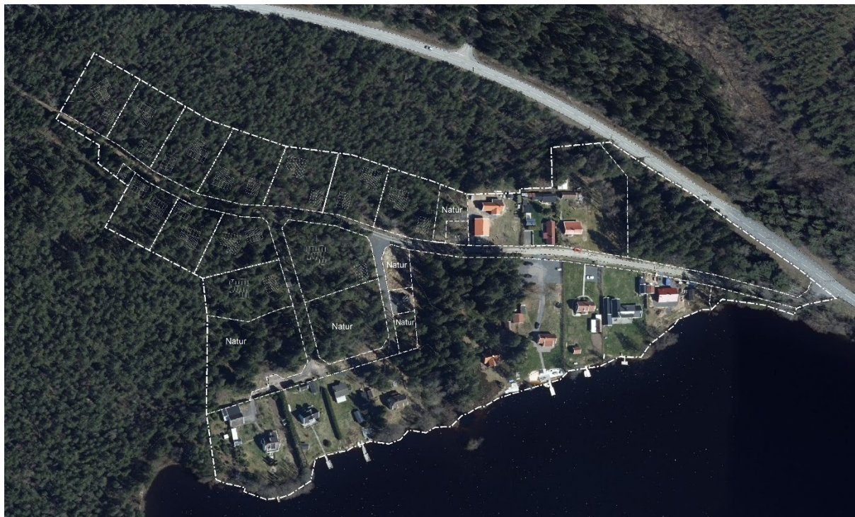
Illustration som visar hur man tänker att de nya fastigheterna kan styckas av.
