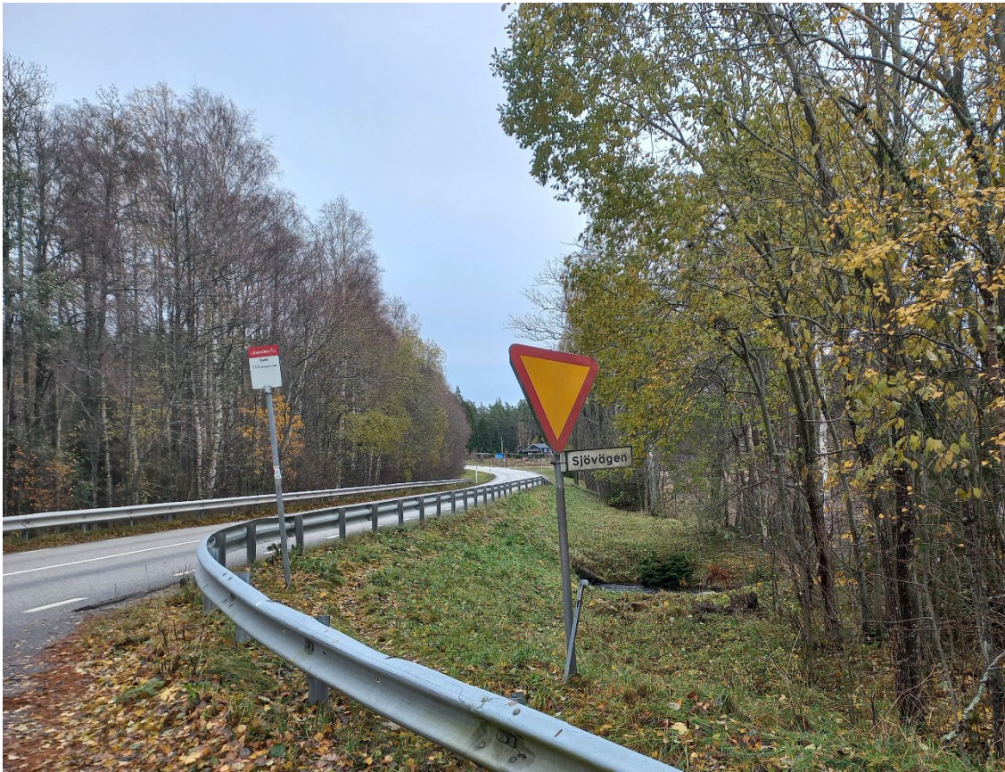
Sträckan mellan planområdet och Fursjö tätort som det ser ut idag, där den planerade gång- och cykelvägen ska ligga, Habo kommun 2023-11-01
