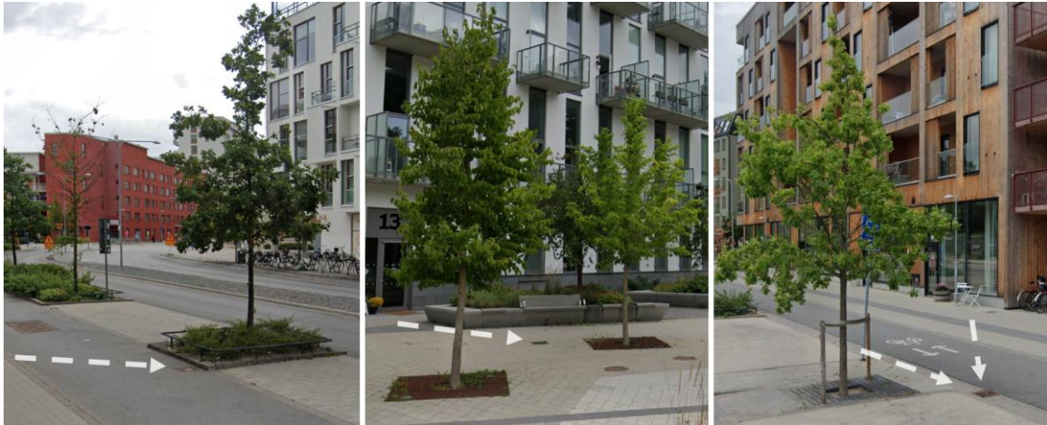
Figur 18 Exempel på dagvattenhantering i samband med trädplantering från Rosendal, Uppsala. Källa: Google
