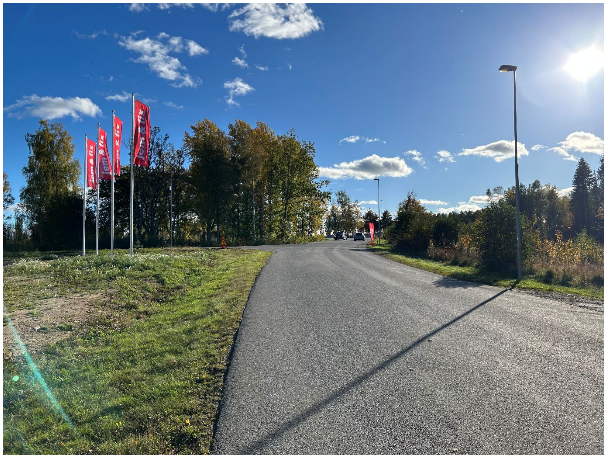
Figur 3: Byggvaruhandeln är öppnad och trafiken har ökat markant. Förslaget innebär att en GC-väg anläggs till höger om Tumbäcksvägen när man blickar mot Kråkerydsskolan.
