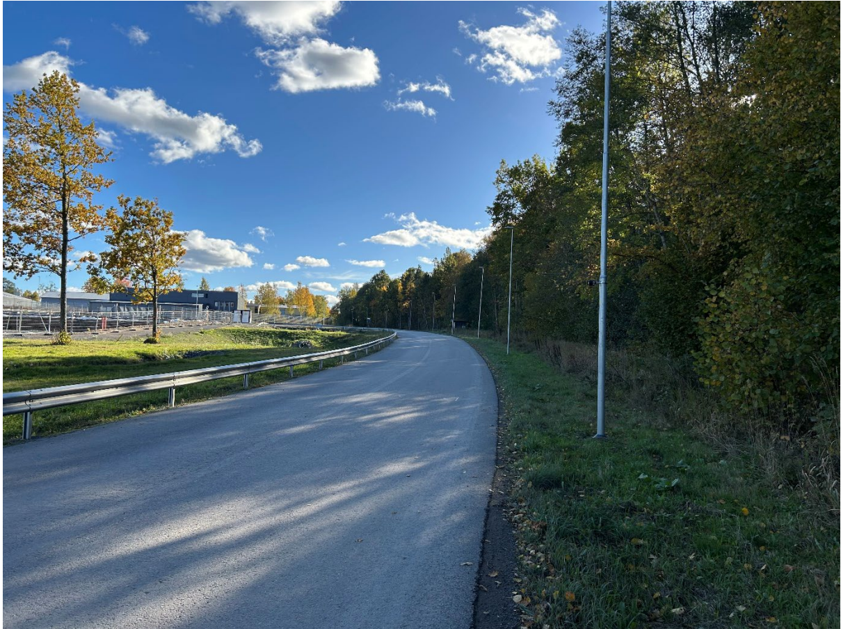
Figur 6: Bilden tagen söderut från Tegelbruksgatan mot Backebogatan. Till höger om Tumbäcksvägen är det planmark. Kanske räcker bredden mellan belysningsstolpar och vägen för anläggning av GC-väg?
