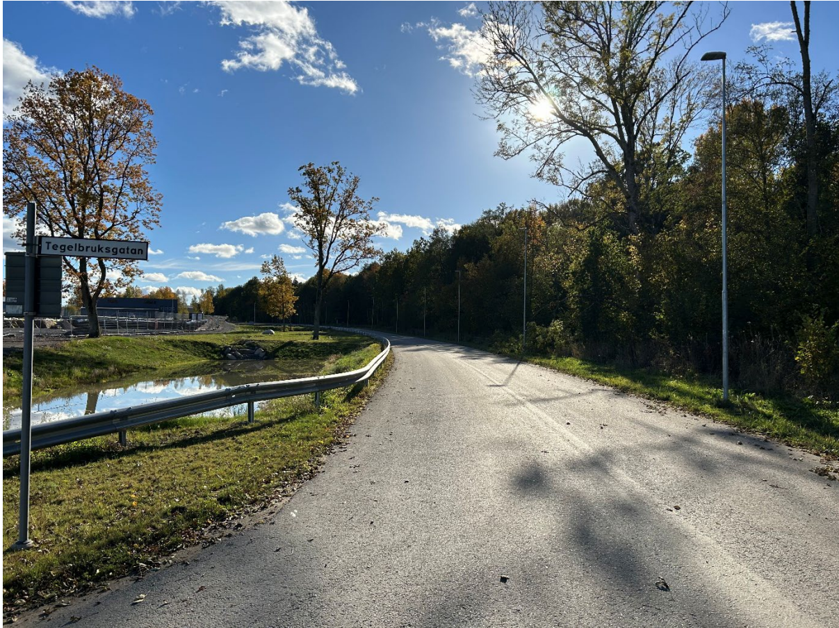
Figur 5: När dagvattendammarna anlades sattes ett vägräcke upp för att förhindra fordon från att köra ner i dammarna. Det gjorde att vägbanan blev smalare, en fotgängare eller cyklist måste gå längre in i vägbanan och riskerar att klämmas mellan räcke och fordon vilket skapar otrygghet.
