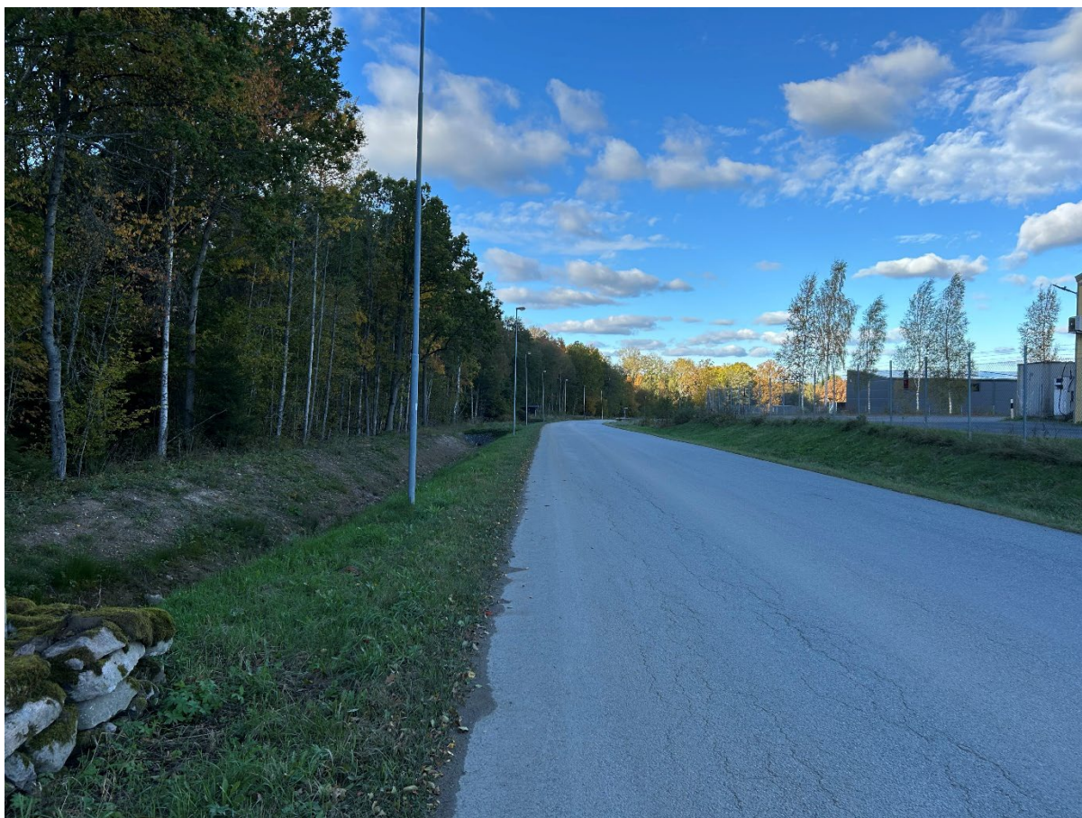
Figur 4: Tumbäcksvägen sträcker sig norrut här i höjd med bussgaraget. Öppet dagvattendike till vänster där förslaget innebär att man antingen lägger ner ett rör och anlägger GC-väg ovanpå eller till höger eller vänster om det öppna diket.
