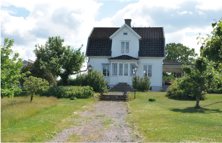
Gunnarsbo 1:61, med brutet tak och frontespis. Huset är uppfört 1929.
