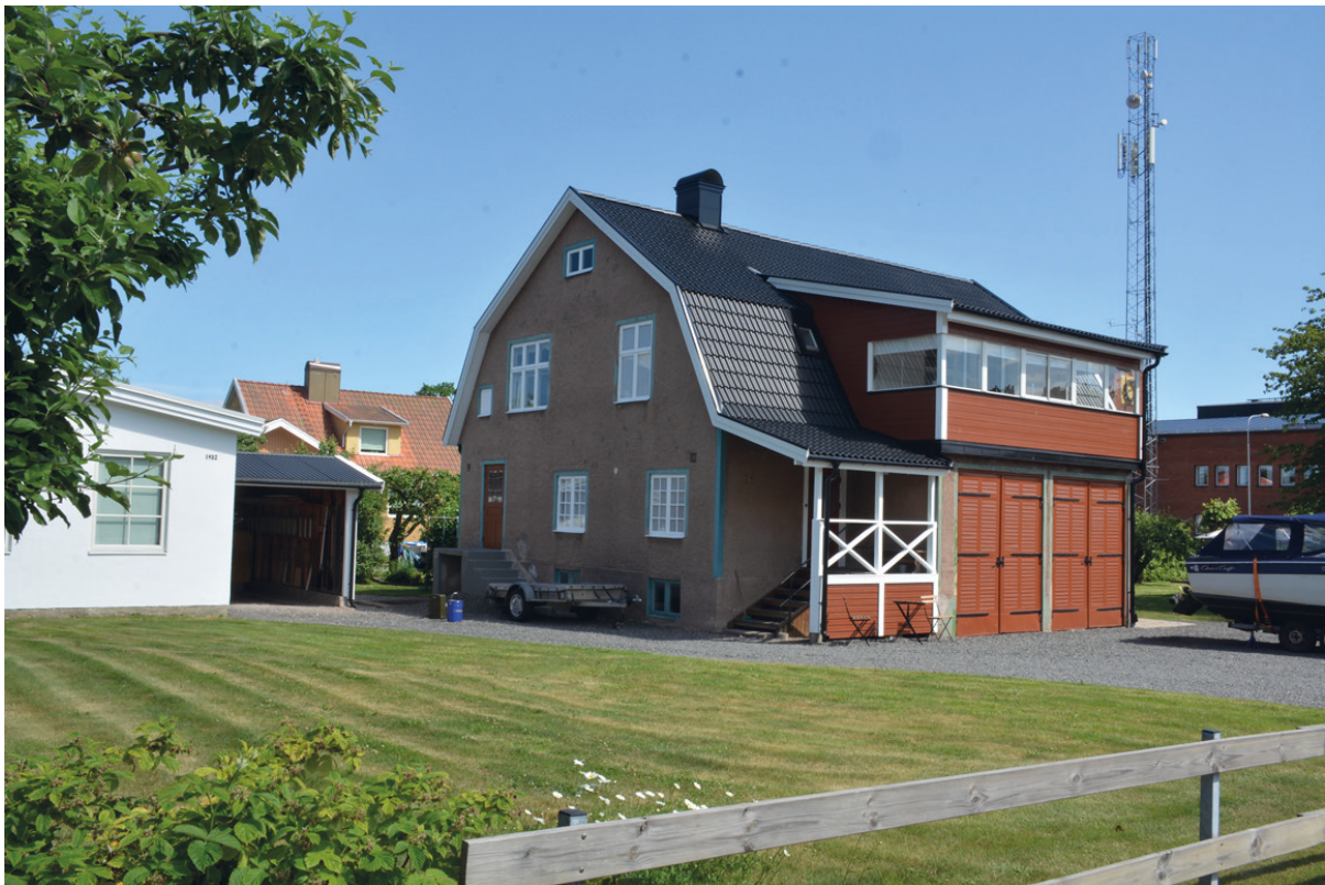
Bränninge 2:96 utgör en särpräglad garage- och verkstadsbyggnad med bostad på andra våningen.
