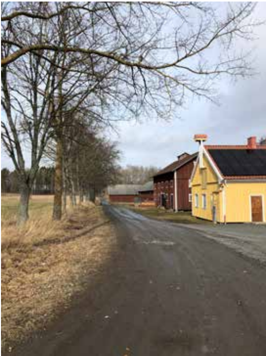
Gårdens Stora Kärrs byggnader (Stora Kärr 1:2) och de allékantade vägarna i området har viktiga kulturhistoriska värden.
