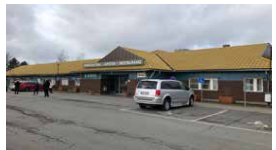
Vårdcentrum (bl a Stora Kärr 8:499) stod klart 1979 och ritades av arkitekt Hans-Erland Heineman, Skövde.
