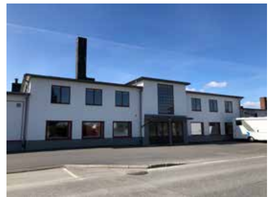
Fabriksbyggnaden till Isakssons metallfabrik utmed Jönköpingsvägen (Bränninge 2:95).
