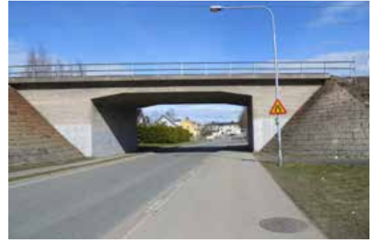
På 1960-talet förlängdes Malmgatan genom en viadukt under järnvägen, vilket gav möjligheter att expandera västerut.
