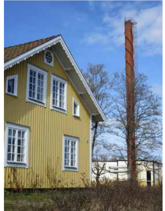
Mangårdsbyggnaden till Lilla Gunnarsbo (1:57) är uppförd 1883 och ligger idag omgiven av industribyggnader i området utmed Fabriksgatan.
