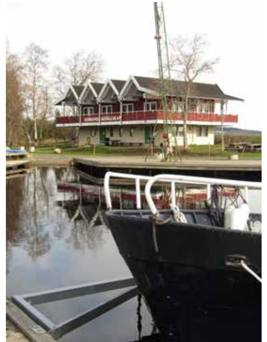
Klubbhuset som förvaltas av Domsands Båtsällskap tillhör en sällsynt byggnadskategori och har en ovanlig gestaltning. Byggnadens sällsynthet påverkar det kulturhistoriska värdet.
