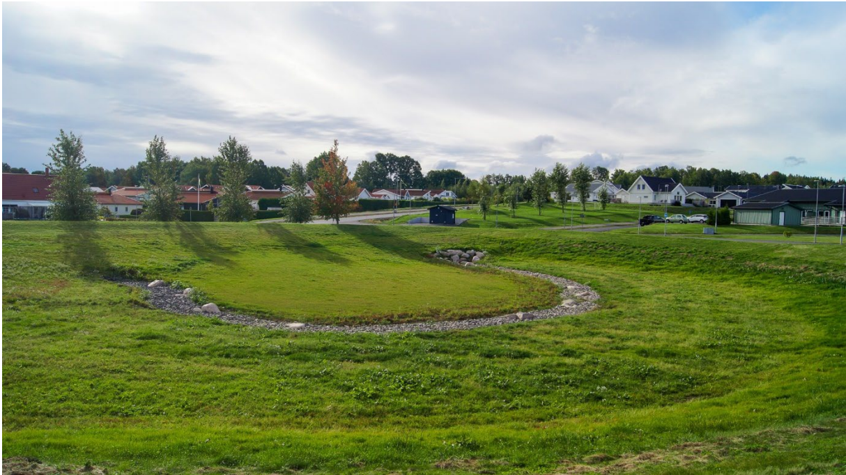
Befintlig dagvattendam i korsningen Bränningeleden – Anders Larssons väg (Foto Sweco).
