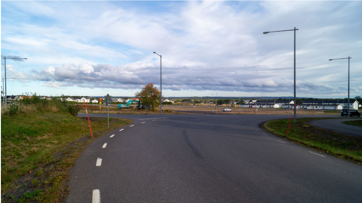
Korsningen Anders Larssons väg/Bränningegatan. Fotot taget från söder (Foto Sweco).
