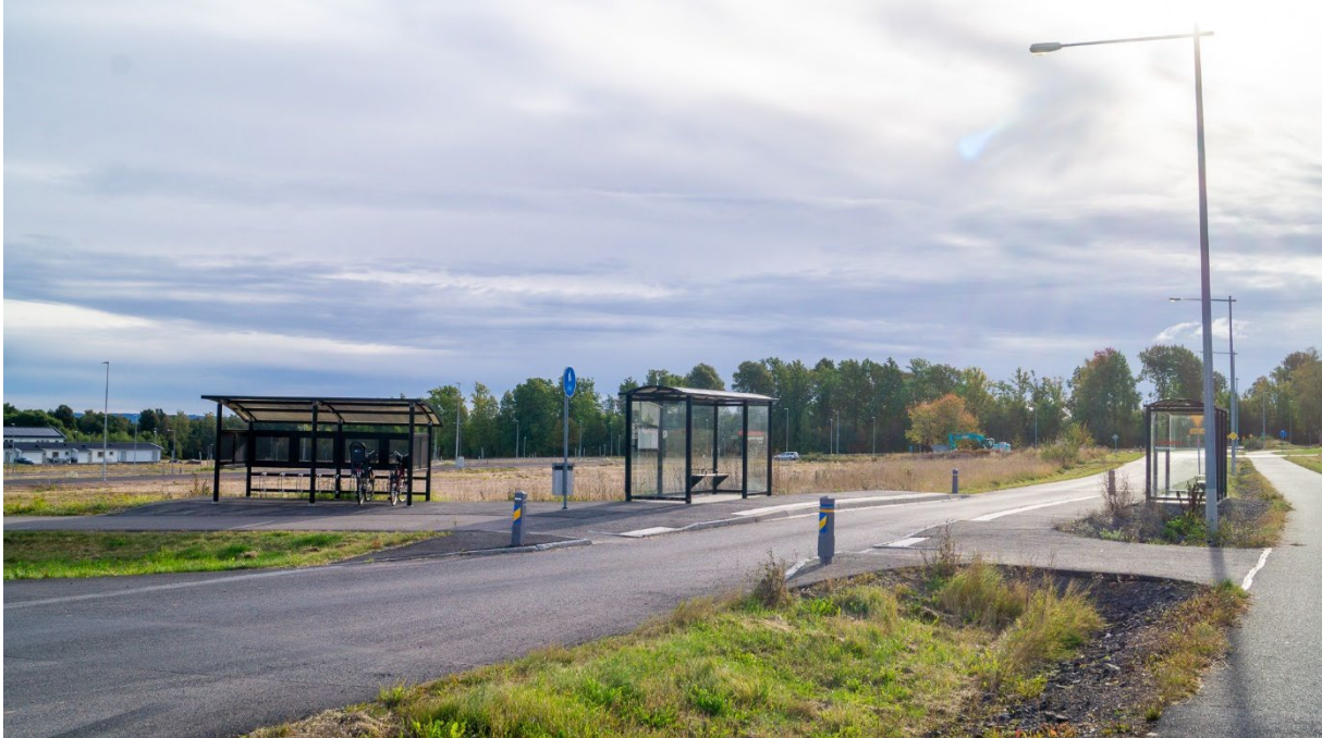
Befintlig busshållplats med cykelparkering, i korsningen Bränningegatan/Tistelstigen (Foto Sweco).
