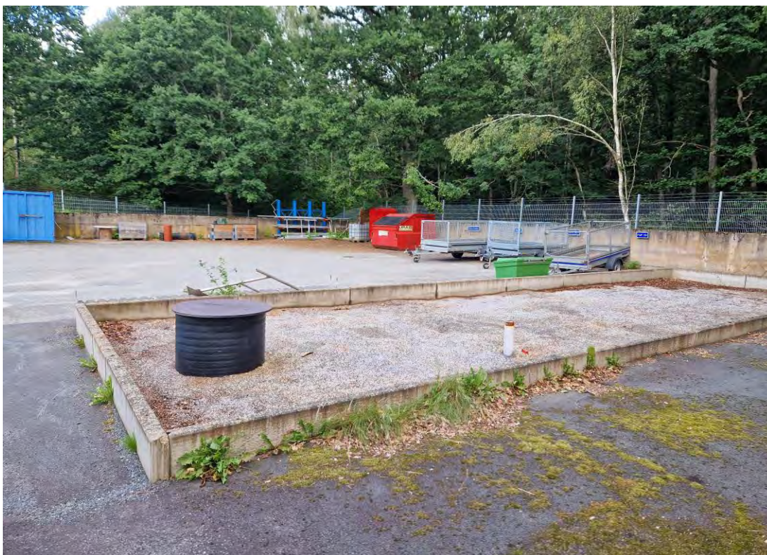
Figur 27. Foto med vy mot nordväst inne på avloppsreningsverket, Habo ARV.
