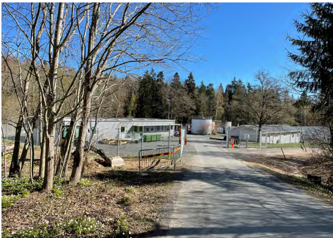
Figur 26. Foto med vy norrut mot avloppsreningsverket, Habo ARV.
