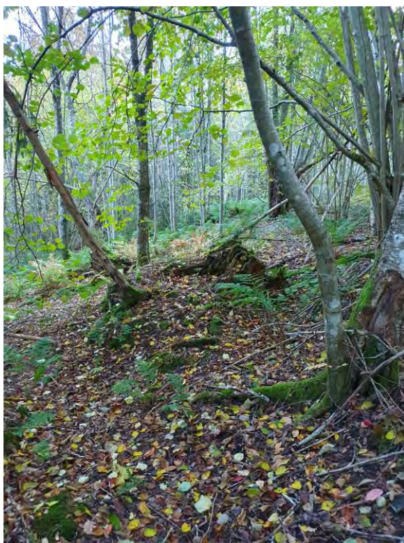
Figur 57. Foto på den södra delen av området upp mot Hembygdsgården. Observera krokiga träd som kan indikera släntkryp.
