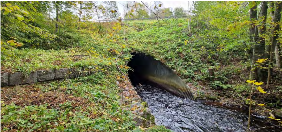
Figur 17. Foto på trumman uppströms, på västra sidan om Hjövågen.
