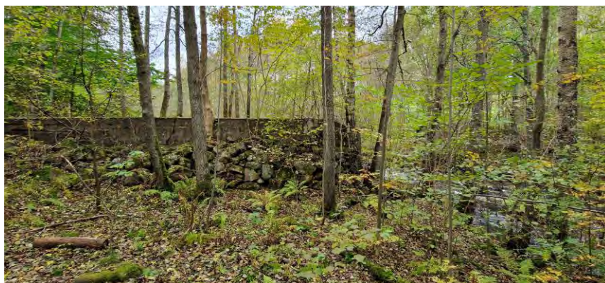
Figur 3. Foto med vy västerut på resterna efter Laggaredammen som revs 2005.
