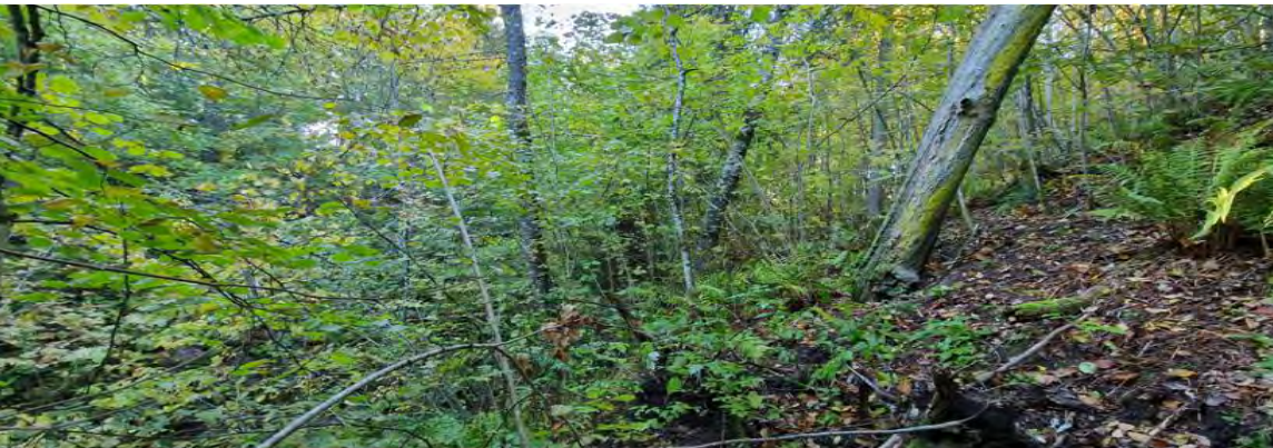
Figur 16. Foto på ravinens västra slänt, med vy söderut. Notera det mindre ytliga raset med det lutande trädet samt markrörelserna i fotots förgrund. Skadan har antingen orsakats av ett mindre ytligt skred, eller av att ett träd har fallit. I bakgrunden syns träd som står snett.
