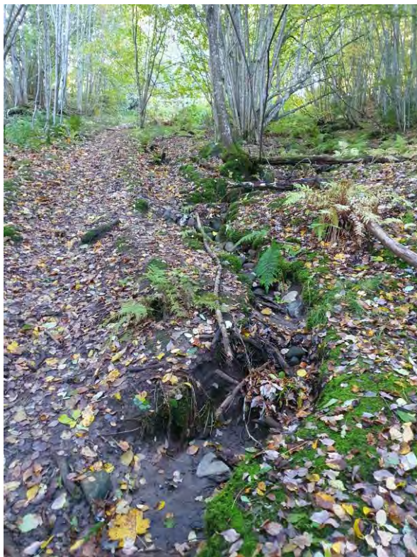
Figur 54. Foton med vy söderut på den södra delen av området upp mot Hembygdsgården. Tydliga tecken på erosionsskador.
