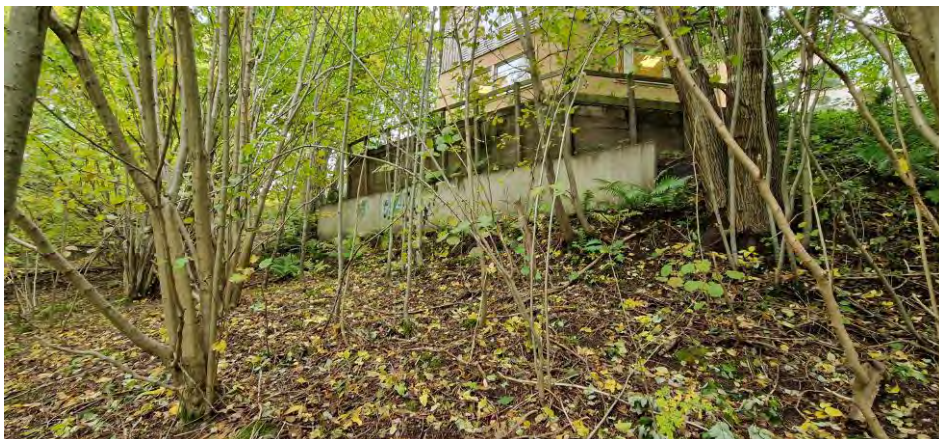
Figur 7. Foto på stödmuren norr om industrifastigheten NordIQ Habo.
