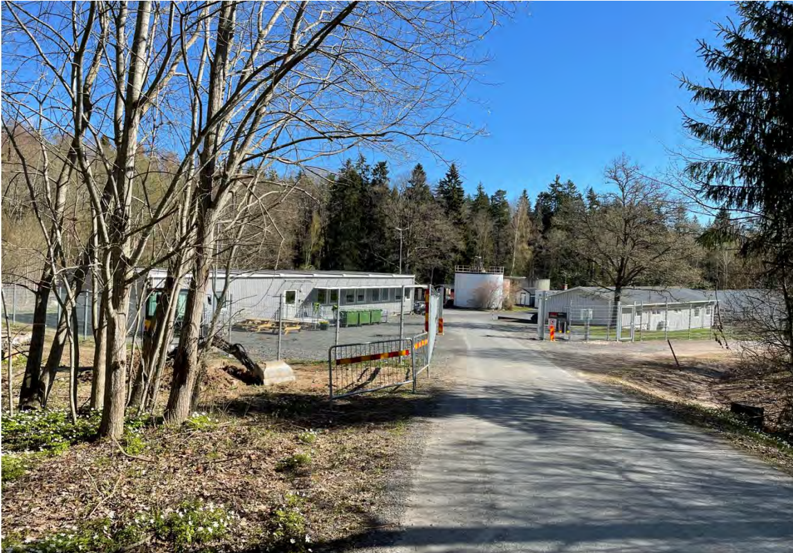
Figur 6. Foto med vy norrut mot avloppsreningsverket, Habo ARV.
