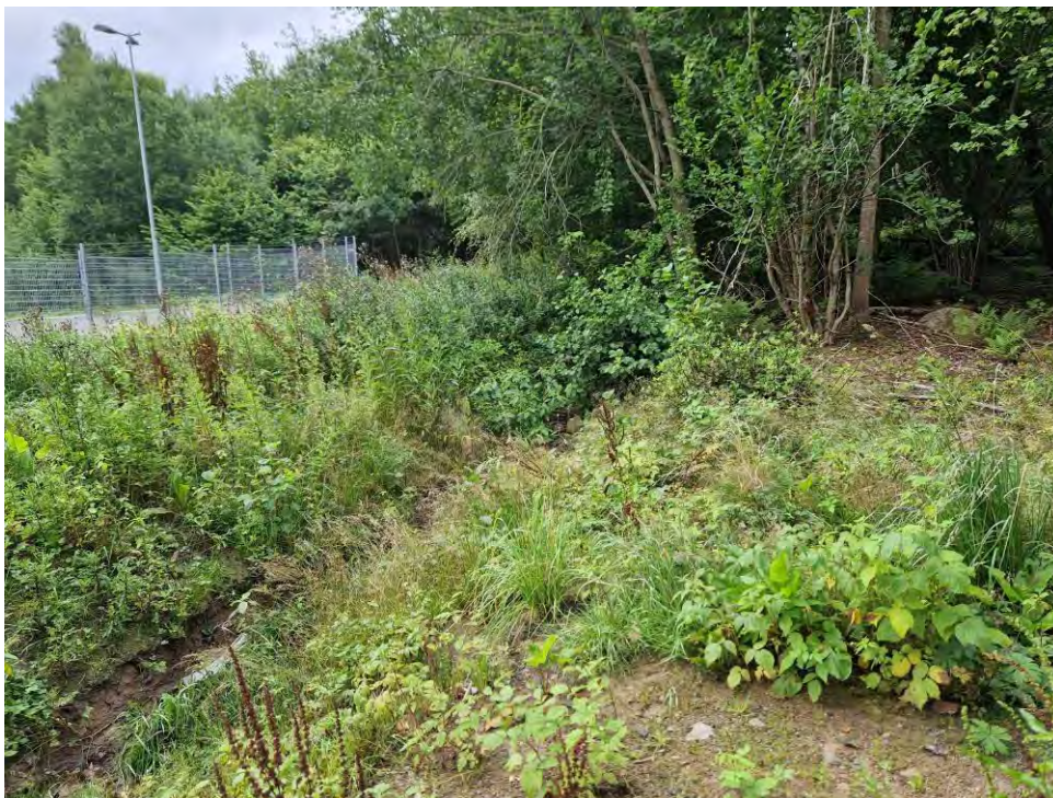
Figur 44. Foto med vy söderut i dräneringsdike direkt väster om befintligt avloppsreningsverk.
