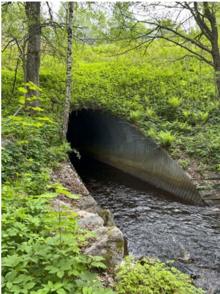
Bron över Hökesån sätt från väster om Hjovägen, foto Sweco.
